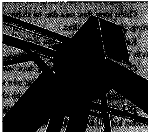
Hình 4.32. Nút dậu giàn ở má hạ và má thượng
