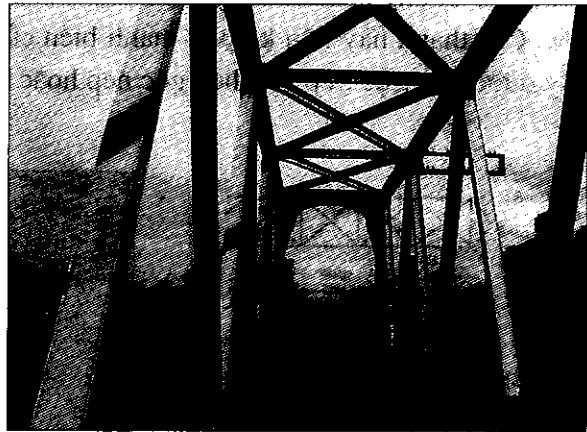
Hình 4.26a: Cấu tạo liên kết dọc trên
